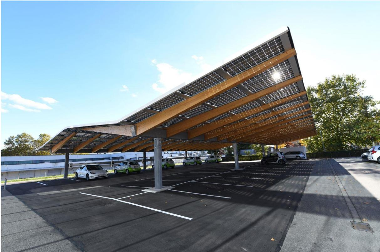
Foto: Das Leuchtturmprojekt INPUT Rheinfelden: Parkplatzüberdachung bestehend aus PV-Glas-Modulen (160 kWp). © Energiedienst AG
